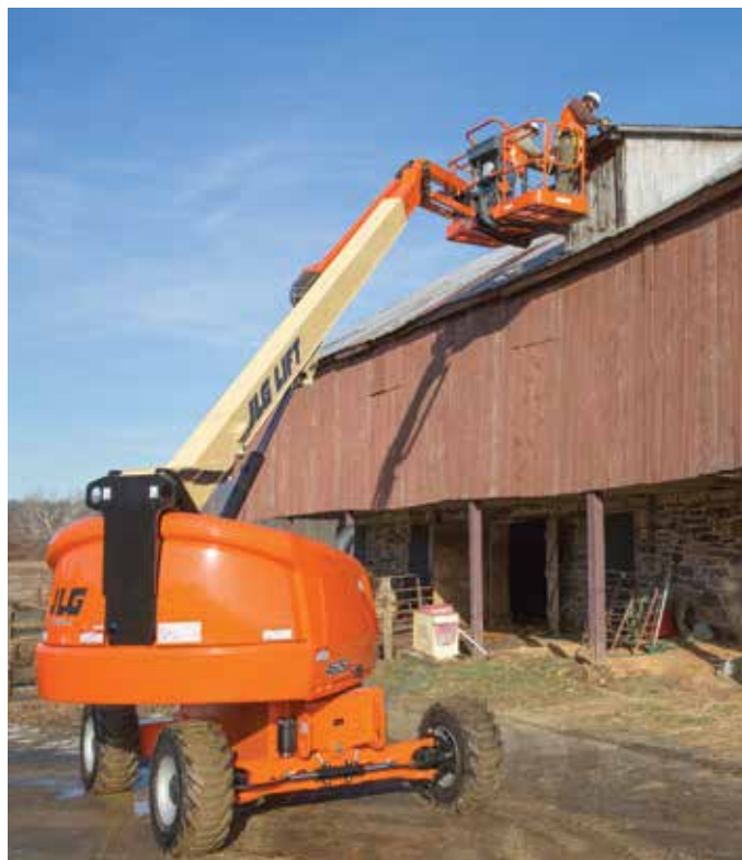
建筑物外部维护
