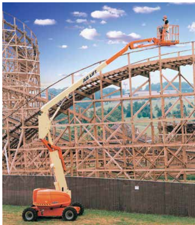
建筑物外部维护
