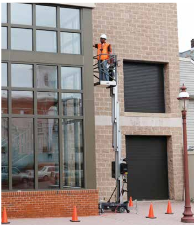
建筑物外部维护
