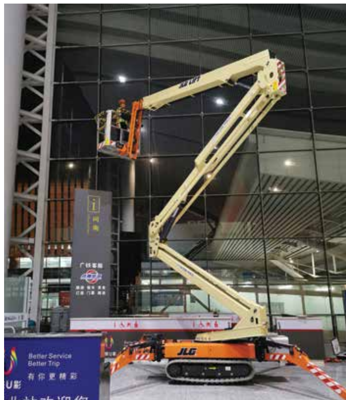
高铁站维护保养
