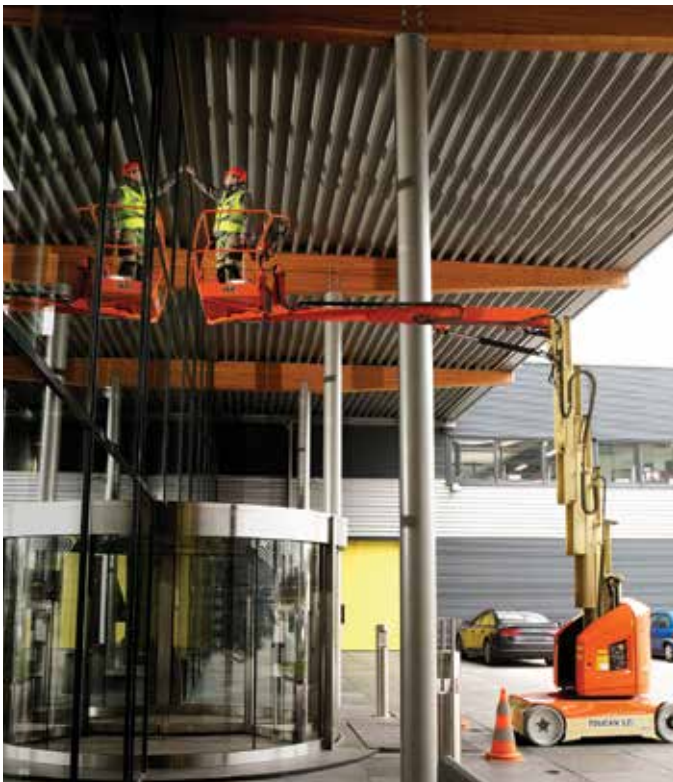
建筑物外部维护
